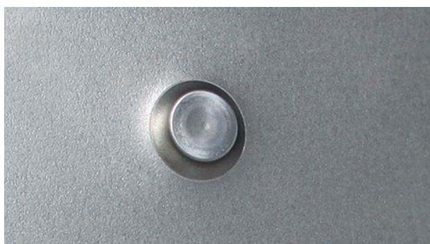
РЕЗУЛЬТАТ УСТАНОВКИ САМОПРОНИКАЮЩЕЙ ЗАКЛЕПКИ
